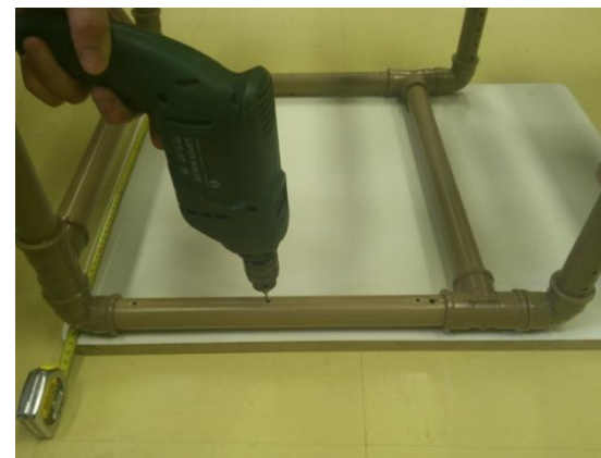
Figura 59. Fixação da chapa base - Passo 3
